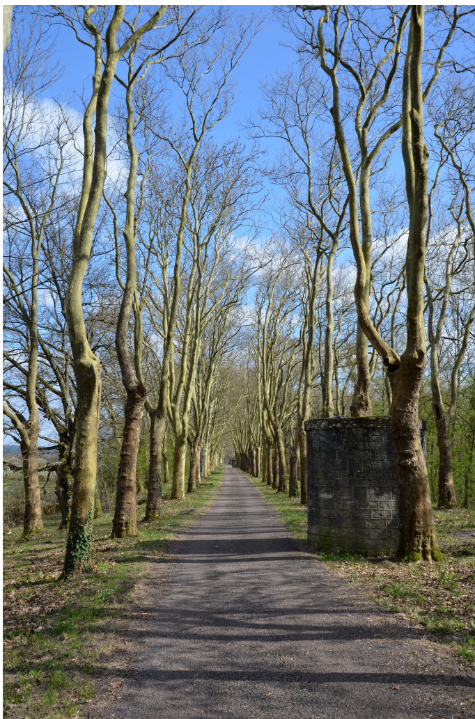
Puits d'aération du tunnel de Pouilly : vestige en surface du percement par trente-deux puits. Pline, CC BY-SA 3.0, via Wikimedia Commons.
